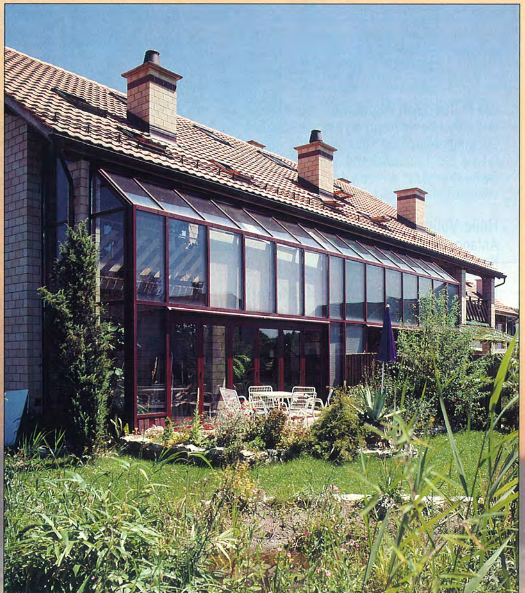
Attraktiv und wirkungsvoll: Passive Sonnenenergienutzung – die am meisten besonnte Fassade wird zum «Wintergarten».
